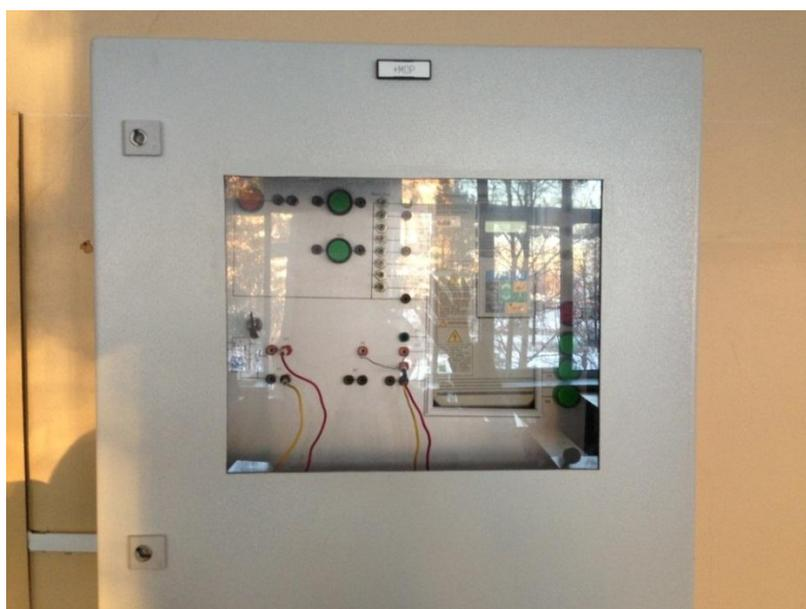
**Рис.5.4.** Преобразователь частоты OMRON
