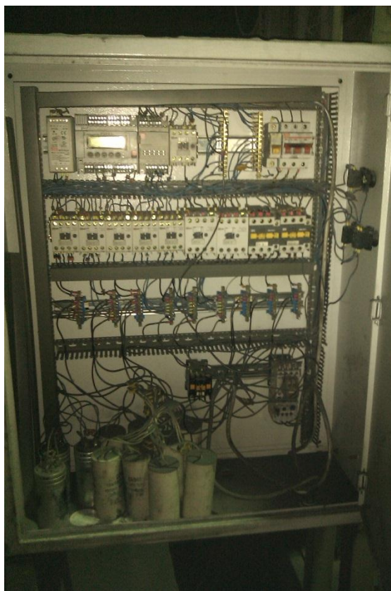
Рис. 5.2. Микропроцессорная система управления с конденсаторным устройством
