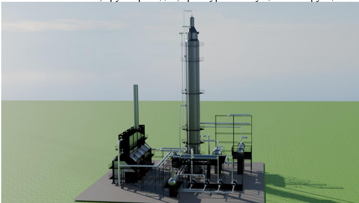
Рис.1. - 3D-модель установки фтористо кислотного алкилирования
